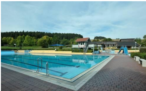
Bild 1: Das Freibad hat neben einem erheblichen Wärmebedarf auch einen hohen Stromverbrauch aufgrund der Wasseraufbereitungstechnik.
