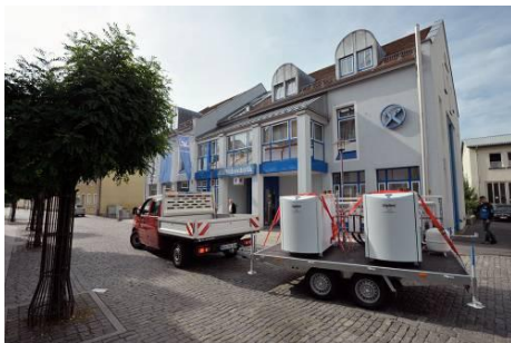
Bild 5: Wenn am Ende der Badesaison die Schließung des Freibads ansteht, kann man die KWK-Anlage problemlos binnen kurzer Zeit zum Rathaus transportieren.
